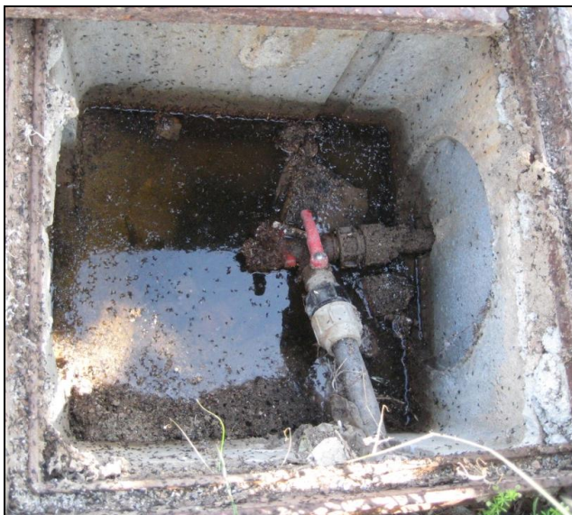
Figura 5: Particolare pozzetto di allaccio.
