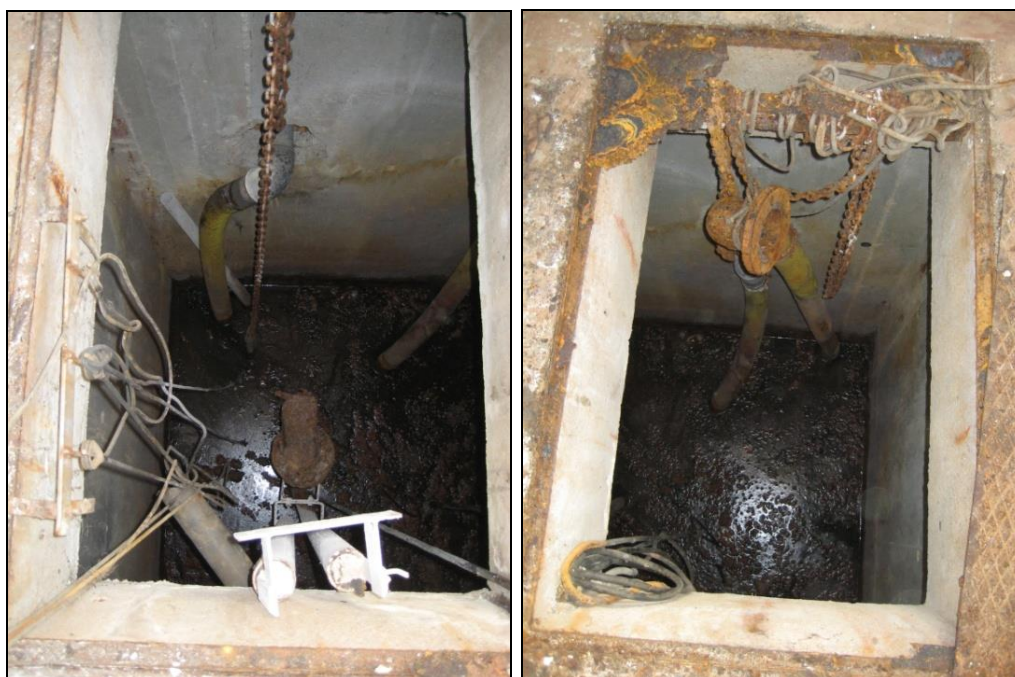
Figura 15: Particolari calate sollevamento acque nere Strada 33.
