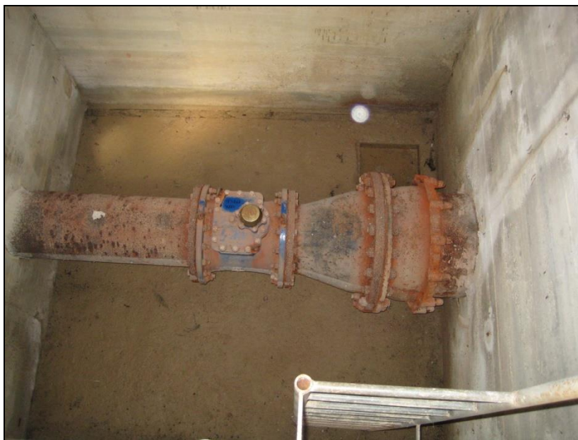
Figura 2: Misuratore master DN 400.
