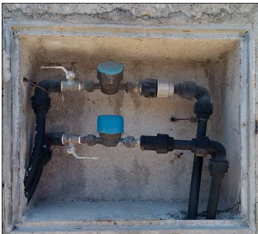
Figura 8: Particolare allaccio in polietilene.
