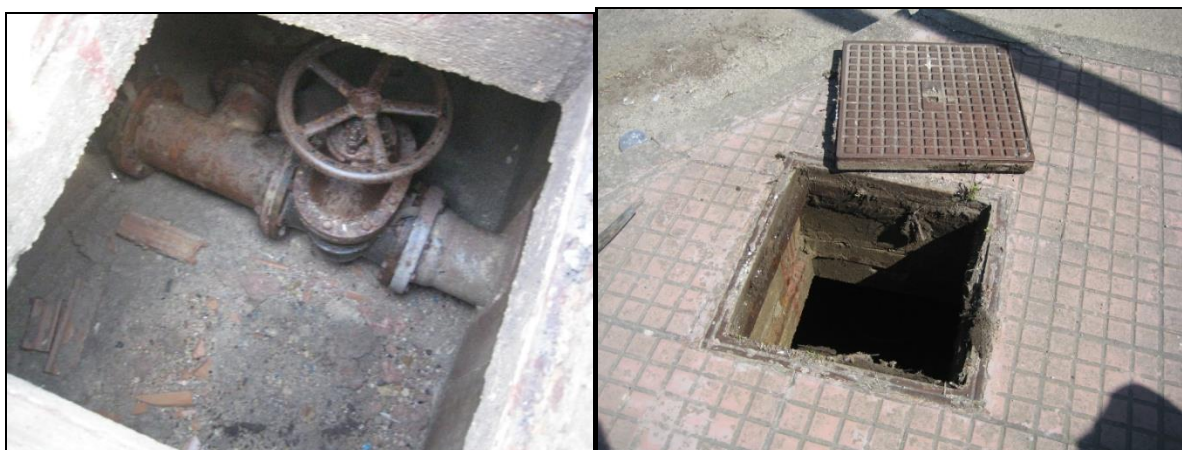
Figura 4: Particolare pozzetto di manovra.
